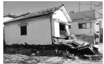
筋交いの多用で建物自体は強くなっていたが、筋交いがつかえ棒となり柱の引抜き力も同時に強くなってしまった。
