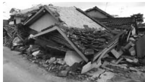
筋交いの少ない事で建物自体が弱く自重を支え切れず1・2階共に崩れるケースが多かった。
